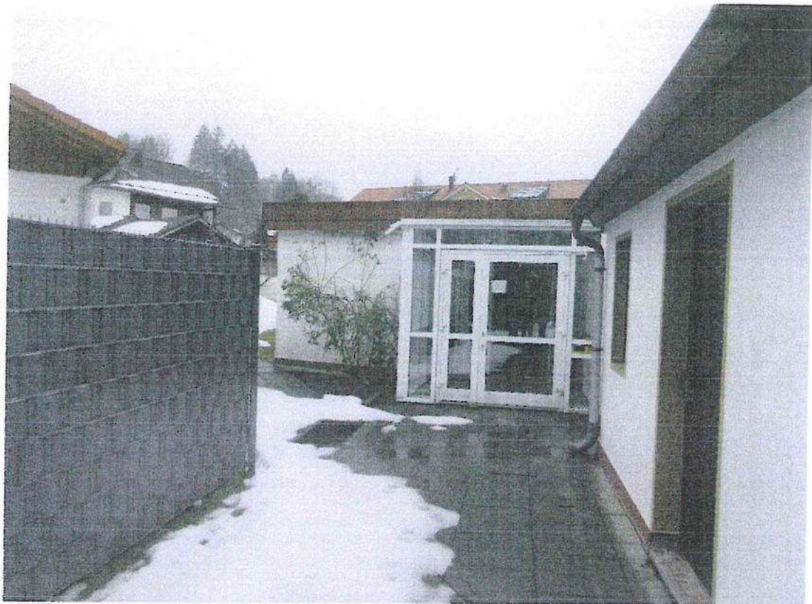
Foto 5: Erdgeschossiger Anbau an der Südseite
