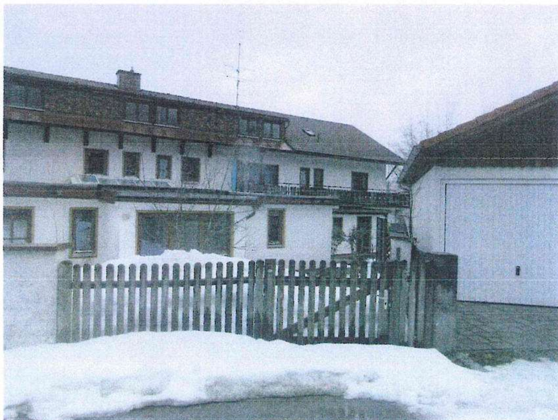
Foto 4: Südfassade des Gebäudes / östlicher Teil
