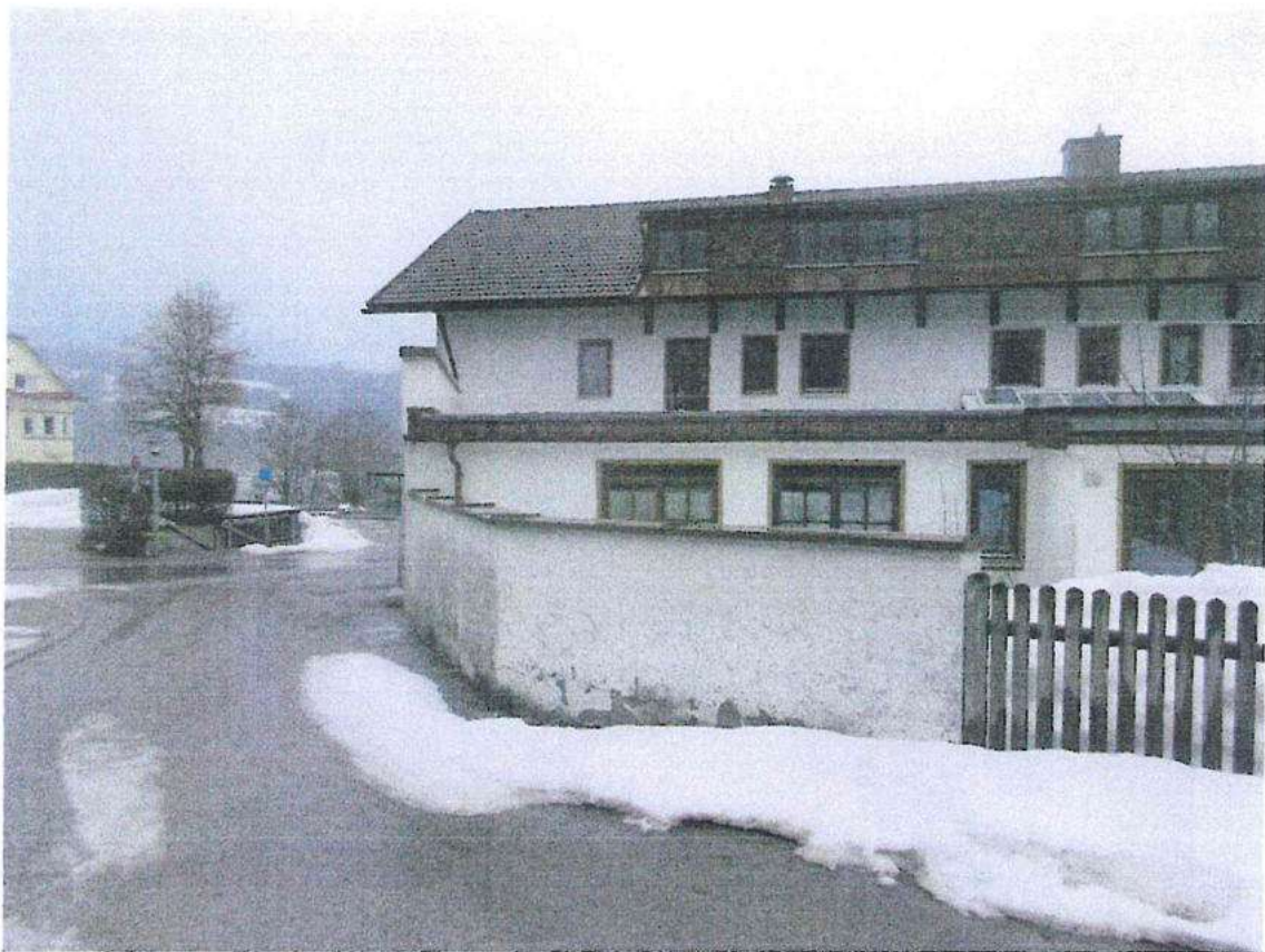
Foto 3: Südfassade des Gebäudes / westlicher Teil
