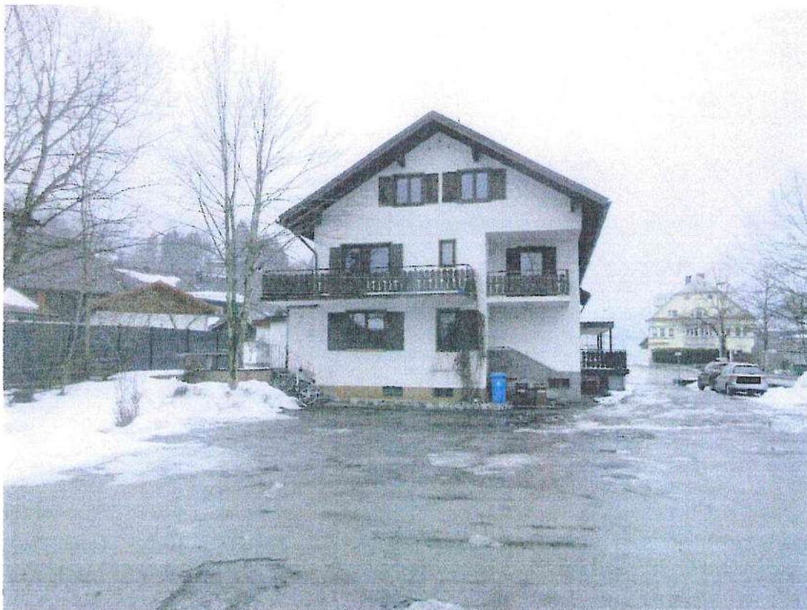
Foto 2: Ostseite des Gebäudes
