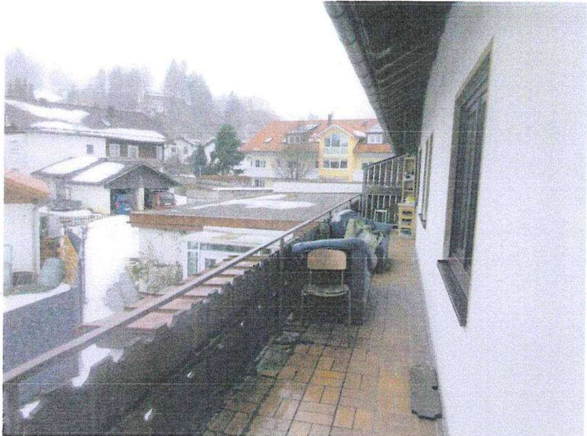
Foto 7: Balkon an der Südseite und erdgeschossiger Anbau nach Süden
